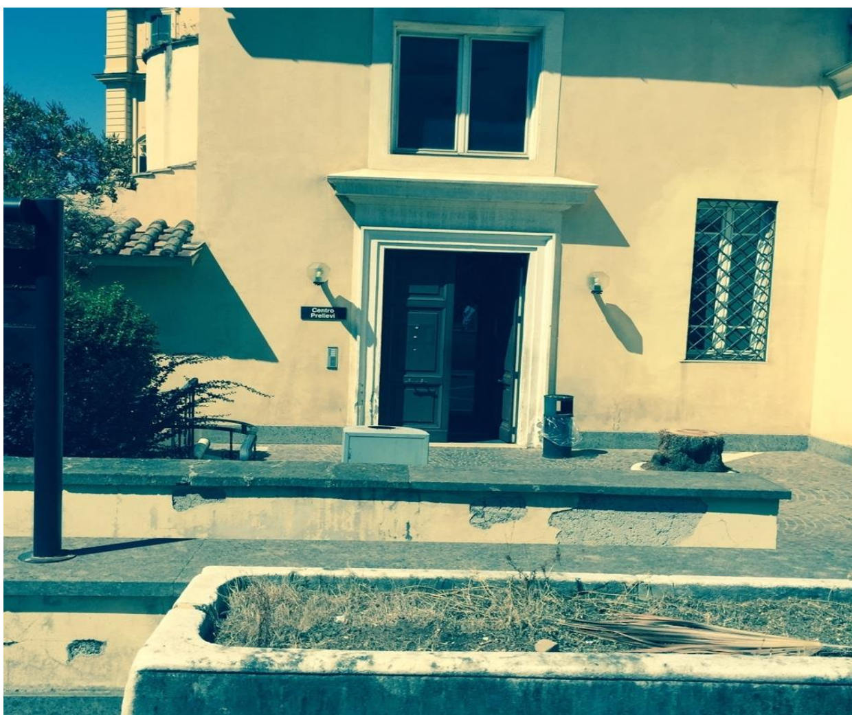
Foto 1: Centro Prelievi “Corpo L” Via San Giovanni in Laterano, n. 155
